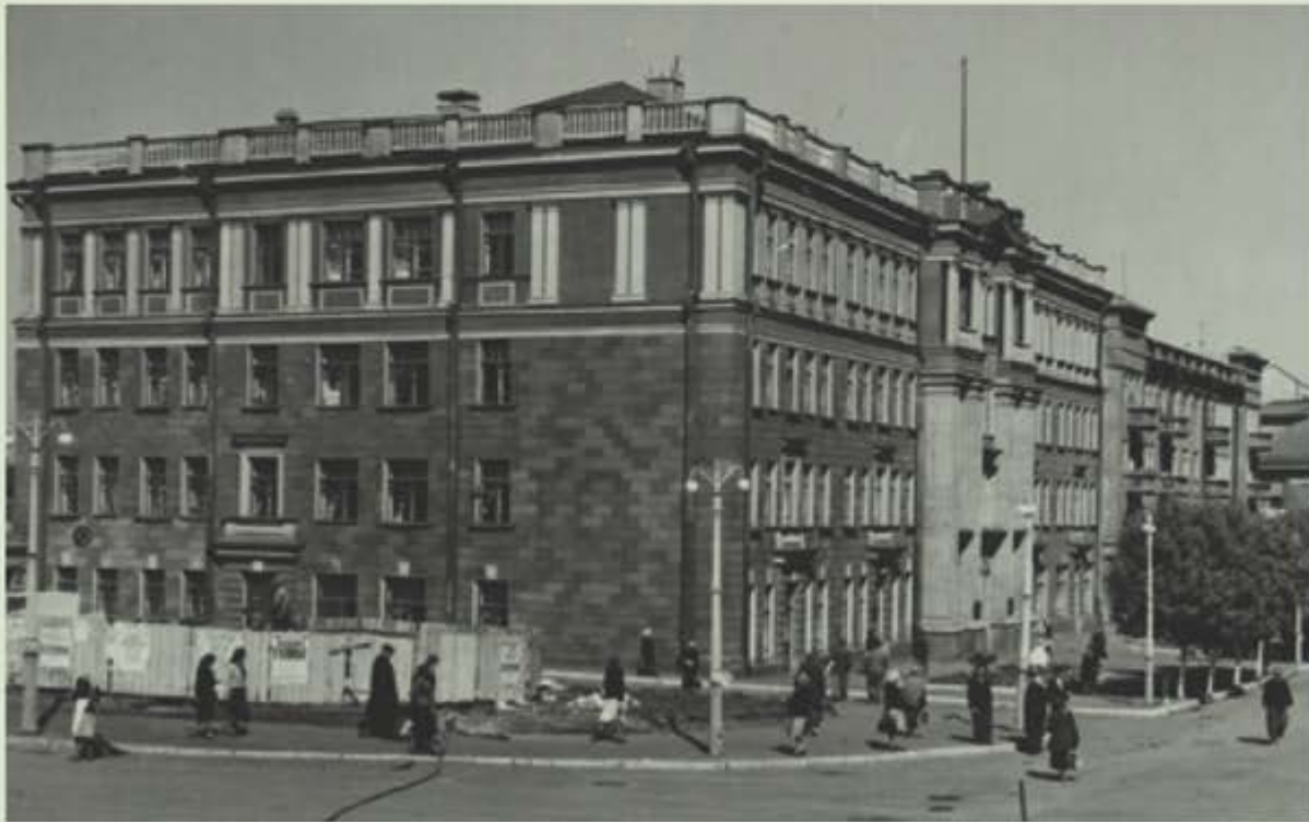
Здание Ворошиловградского областного комитета КП(б) Украины. Ул. Пушкинская, 8. Достройка четвертого этажа и реконструкция фасадов произведена по проекту арх. И.Ф. Минько.
