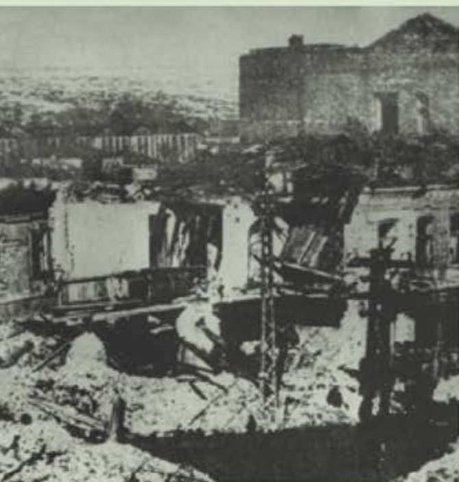
Разрушения в городе на углу ул. Пушкинской, 1943 г.
