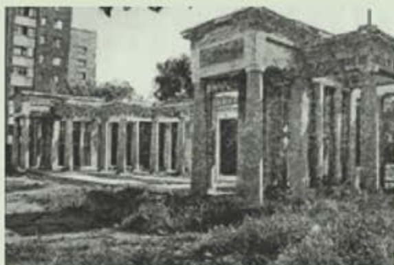
Полуразрушенная колоннада парадного входа в ПКЮ им А.М. Горького. Снимок 2009 г.
