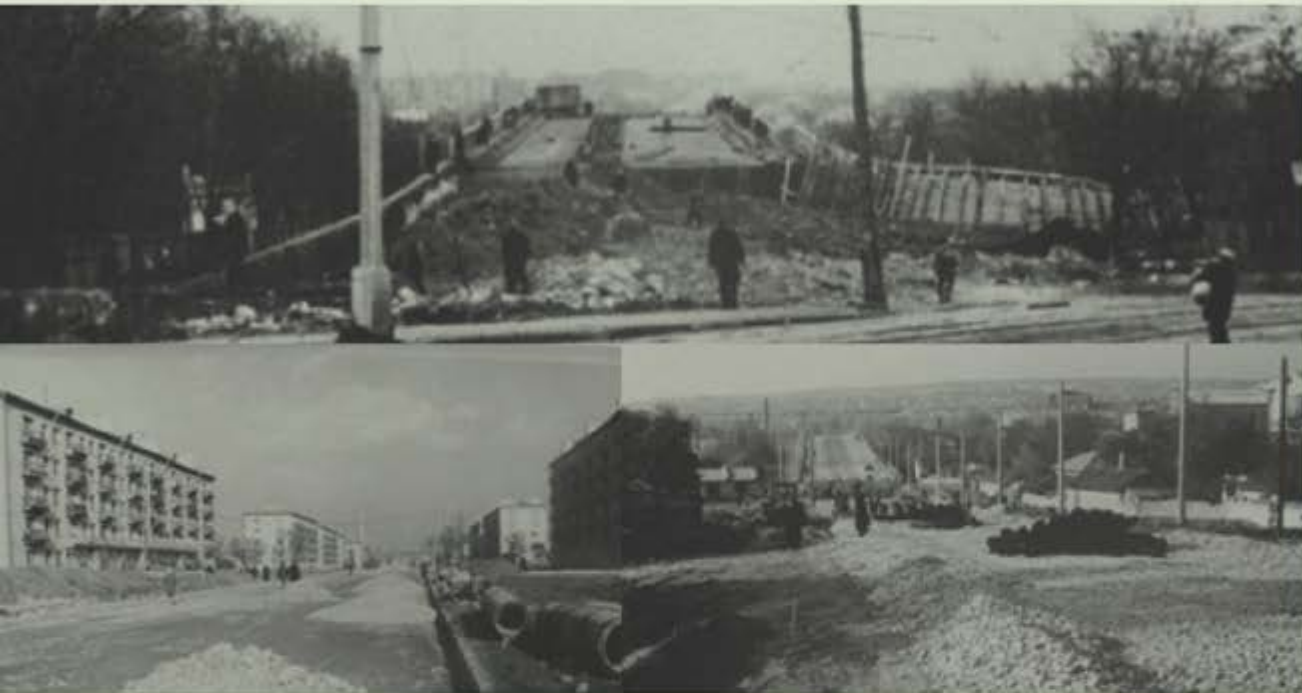
Будівництво нових транспортних магістралей. 60-і рр.
