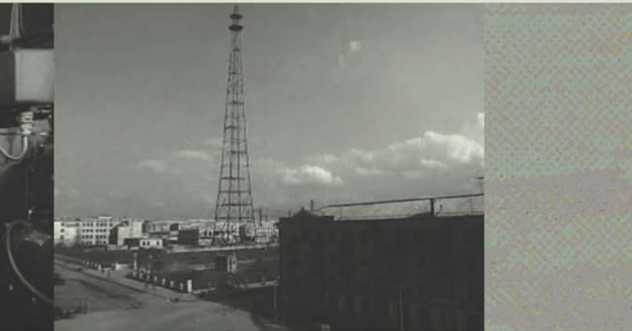
Здание телецентра в г. Ворошиловграде. Автор проекта арх. Б.И. Барсуков. 1957 г.
