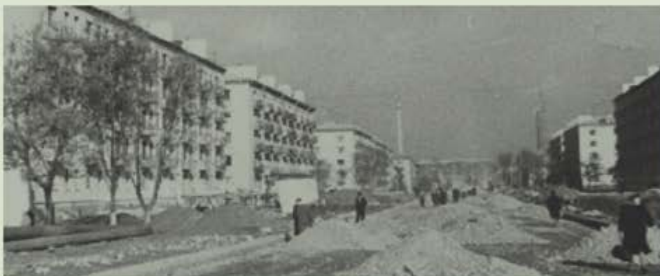
Строительство дороги на ул. Чапаева. 1965 г.
