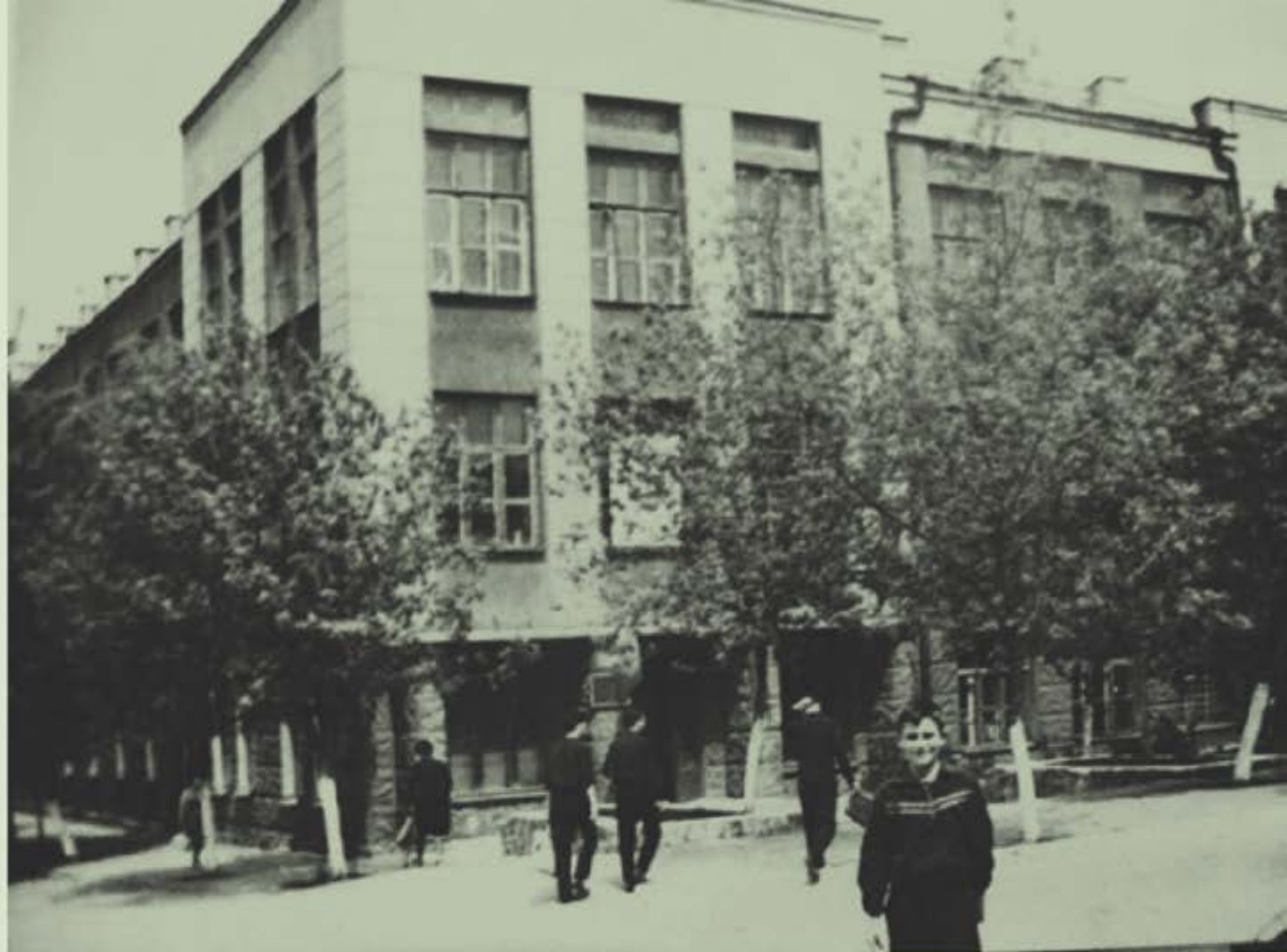
Школа №2. Проект надстройки второго этажа, выполнен инж.-арх. Г.Н. Нероном. Фото 1963 г.
