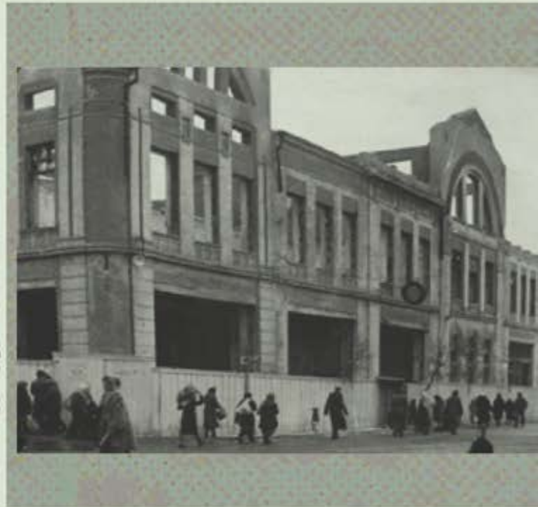
Разрушенный фасад дома по ул. Ленина, 38. 1943 г.
