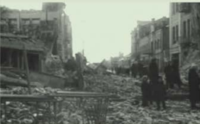
Разрушения в городе Ворошиловграде. Угол ул. Пушкинской и Ленина. 1943 г.
