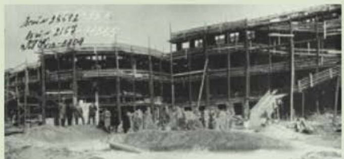
Строительство педагогического института. Арх. А.Г. Молокин.
