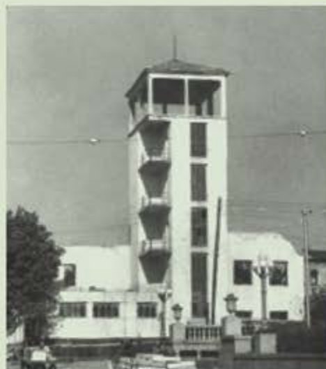
Пожарное депо. Красная площадь. 1950 г.
