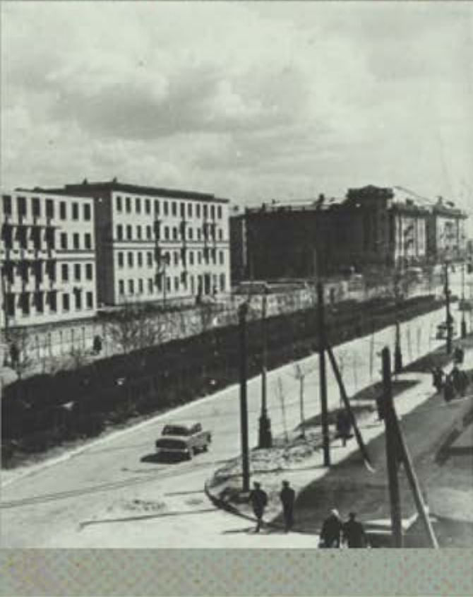
Строительство квартала жилых домов совнархоза (позже облсполкома). Арх. Л.Е. Иванов. 1957–60 гг.
