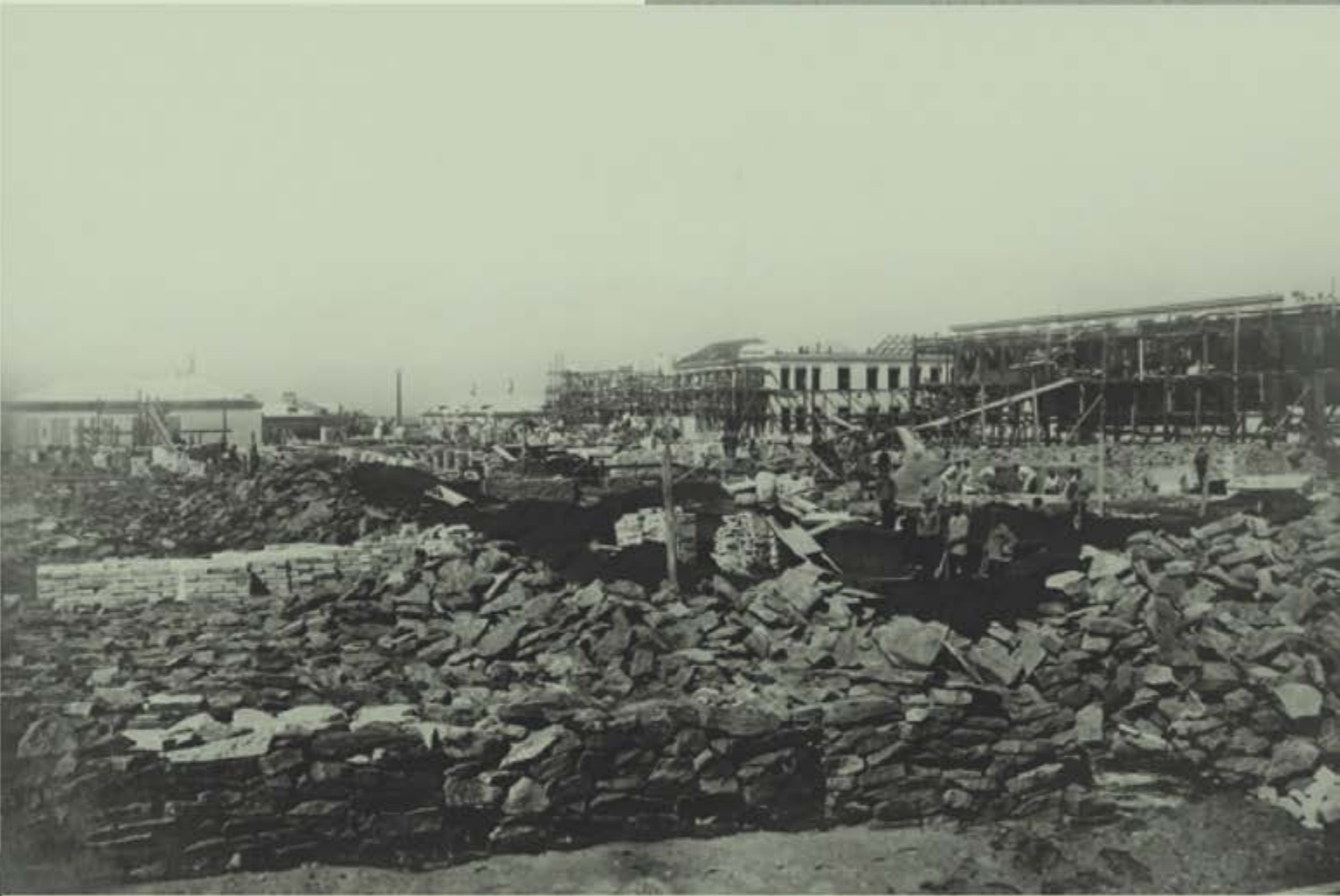
Строительство Луганской окружной больницы. Проект инж.-арх. Г.Н. Нерона. 1926 г.
