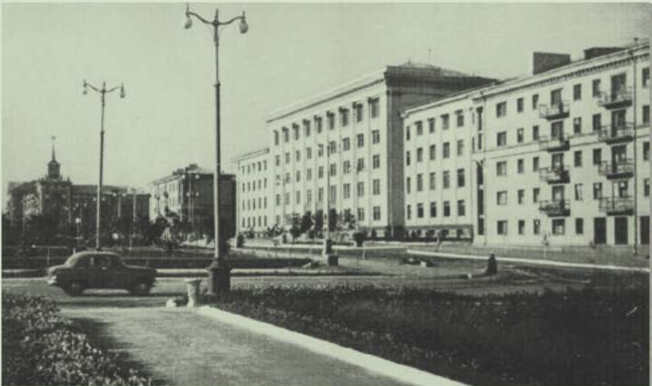
Главный фасад здания облисполкома. 1959 г.
