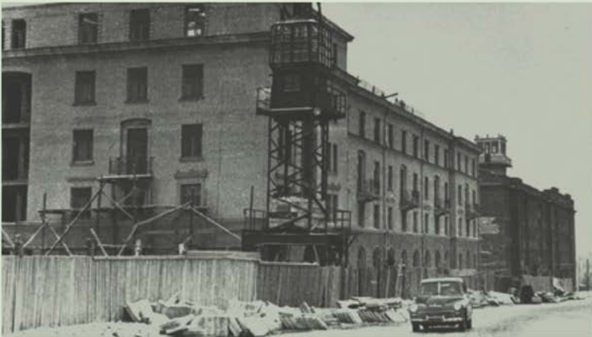
Общежитие завода им. Ленина. Ул. Котельникова, 1. 1953 г.
