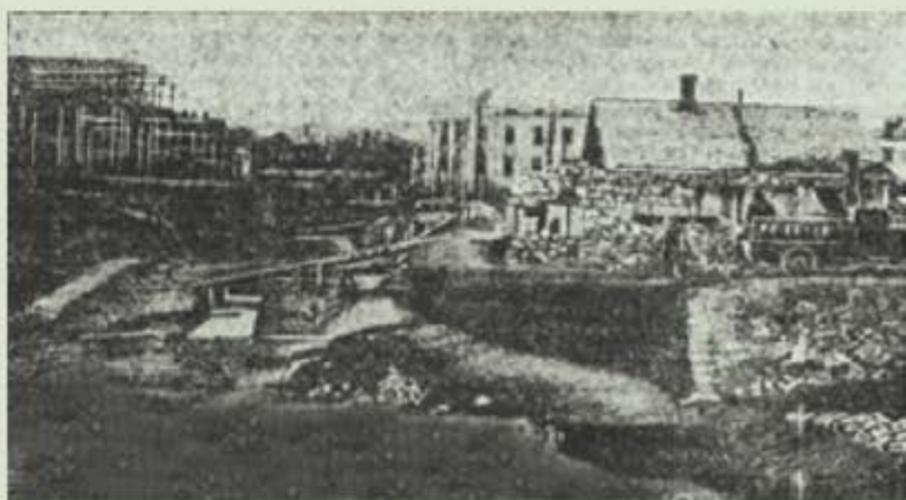
Разрушения на Пушкинской улице. 1946 г.
