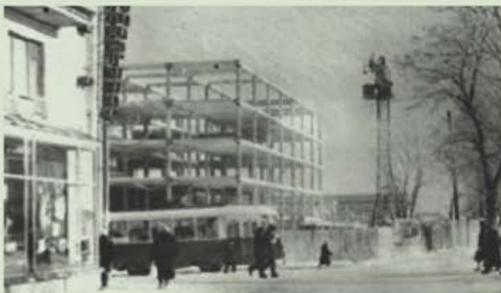
Строительство Дома быта. Вид с ул. Советской. 1967 г.
