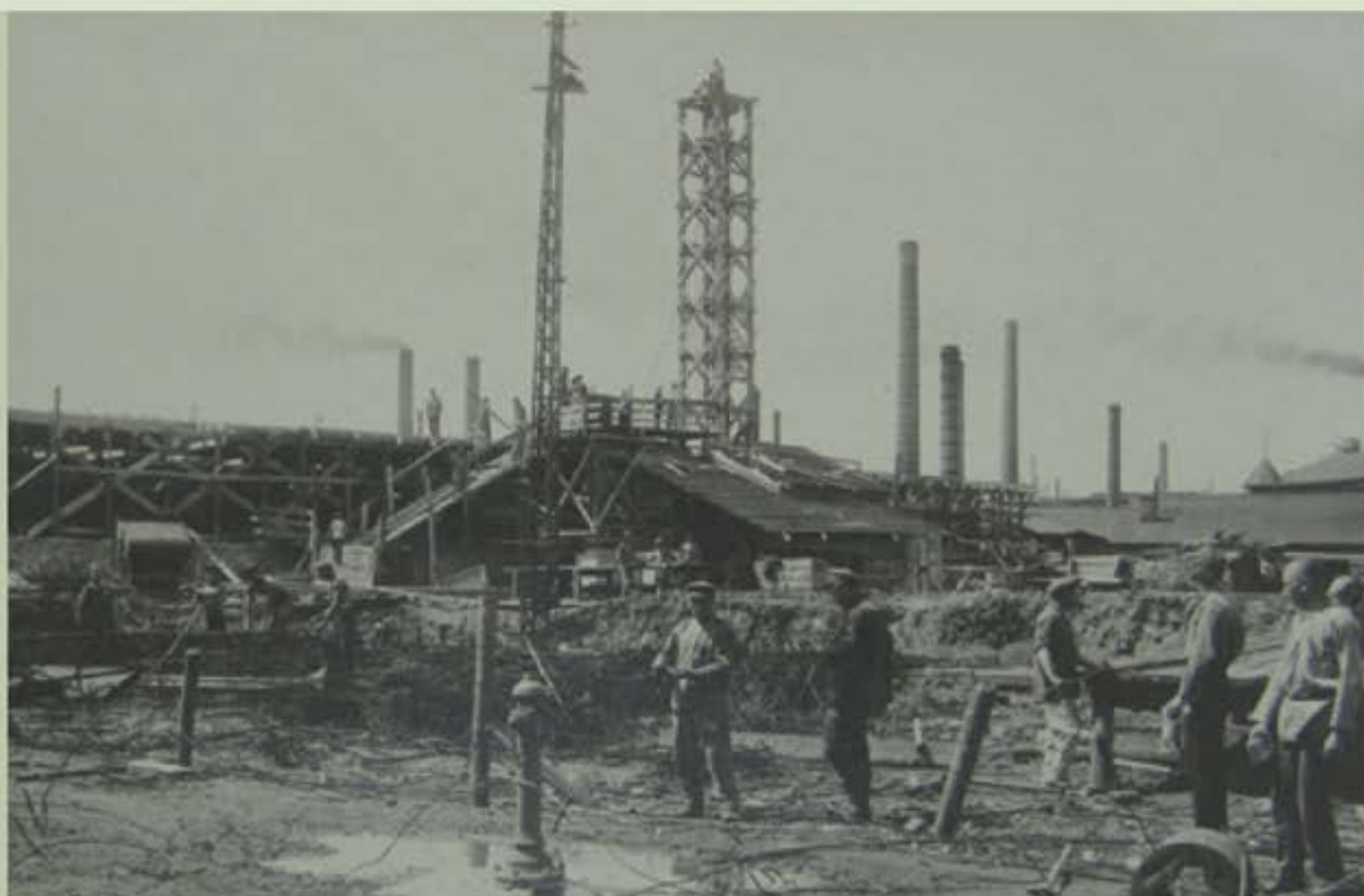
Строительство паровозного отдела завода им. Октябрьской Революции. 30-е годы.
