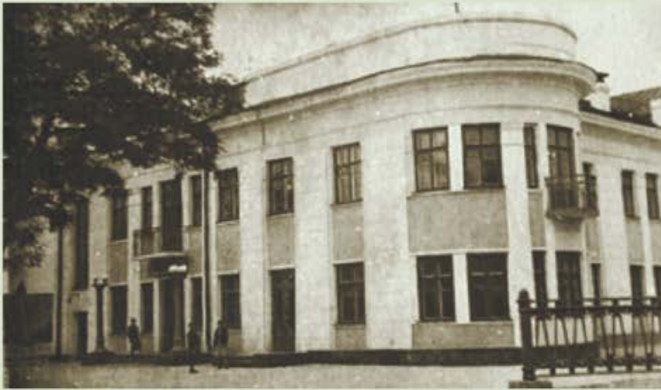
Дом молодых специалистов завода Октябрьской революции. Участок им. Цупова. Арх. Дмитриенко. 1951 г.
