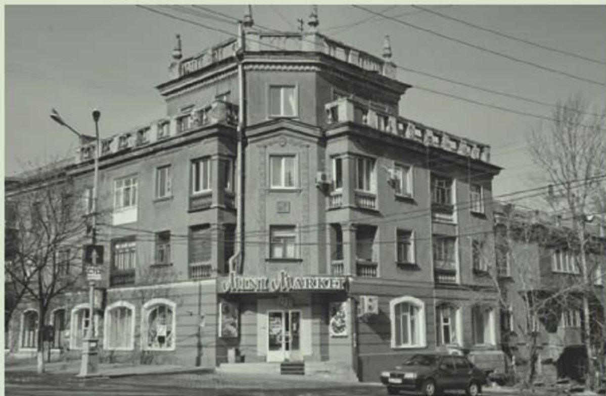
Жилой дом. Ул. К. Маркса, 9. Арх. Т.А. Николенко. Фото 2011 г.
