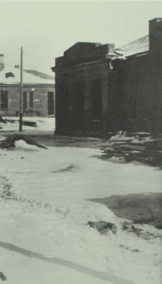
Общий вид строительства главной улицы Луганской окружной больницы.
