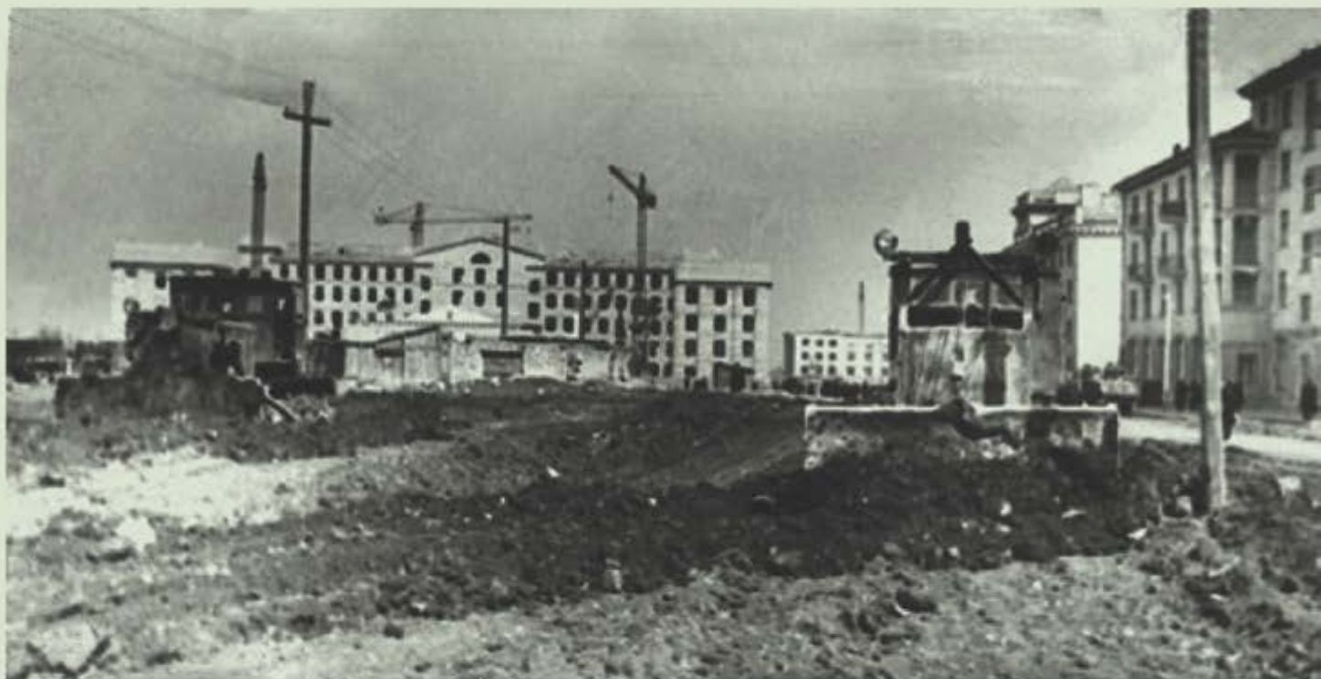
На центральной площади сносится последний барак. 1955 г.
