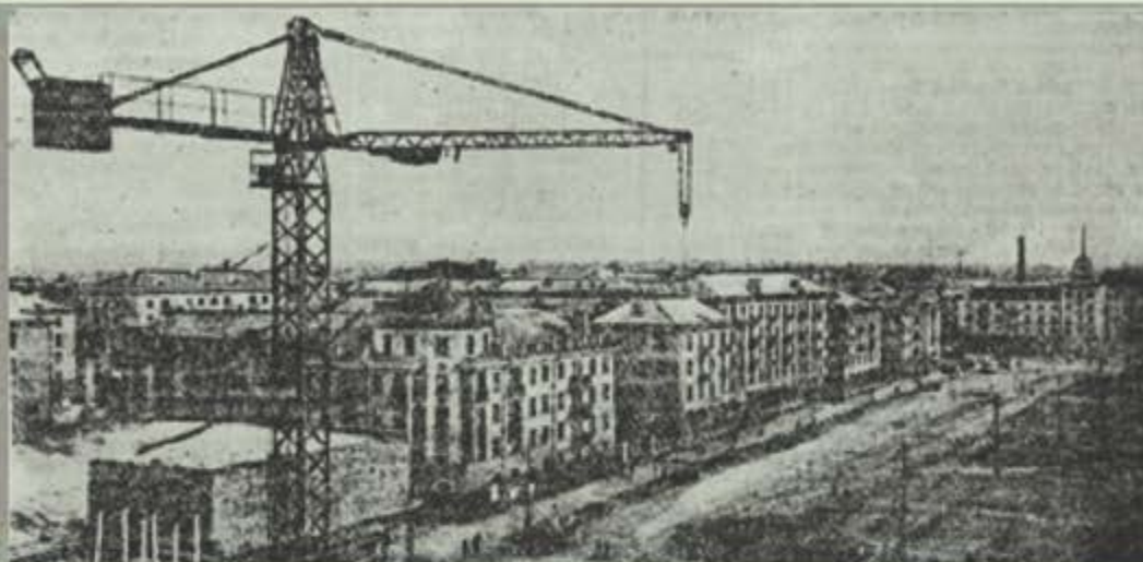
Строительство новых жилых домов и здания Дома советов на Сенной площади. Восточная сторона – арх. Г.Р. Каминский, Т.А. Николенко. 1958 г.
