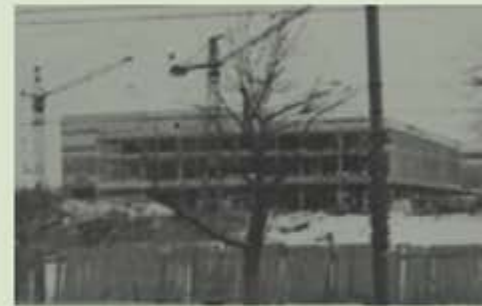
Строительство универмага «Россия». 1969 г.
