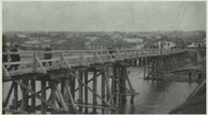
На седьмой день был построен мост через реку Лугань. 1943 г.
