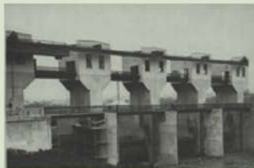
Плотина и мост через р. Лугань в Малой Вергунке.
