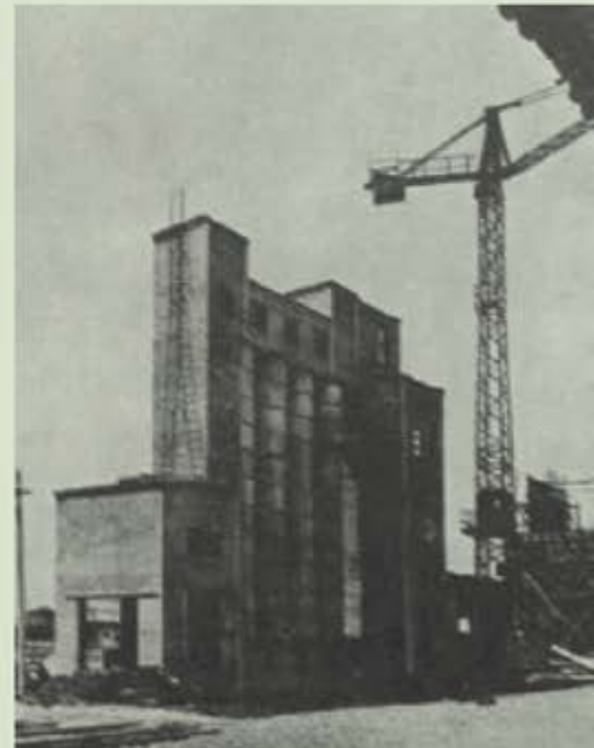
Завод ячеистого бетона. 60-е гг.
