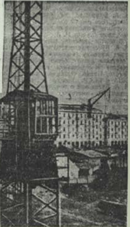
Строительство новых жилых домов для паровозостроителей на бывшей Сенной площади. 1956 г.
