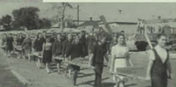
На стройке стадиона. 1950 г.
