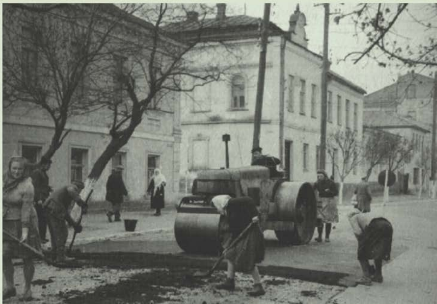
Асфальтирование дороги на ул. К. Маркса. 1951 г.
