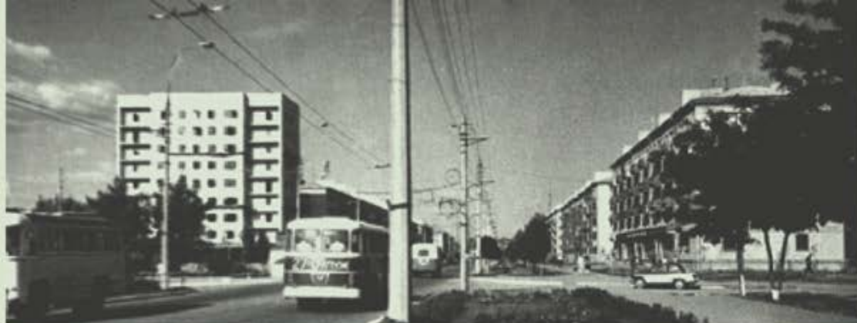
Первое высотное здание – девятиэтажный жилой дом. Квартал им. Гаевского. 1969 г.
