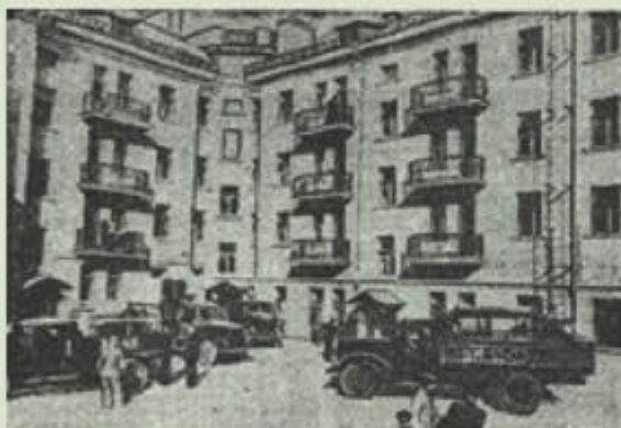
Жилой дом на центральной площади для паровозостроителей. Арх. Г. Каминский, Т. Николенко. 1956 г.
