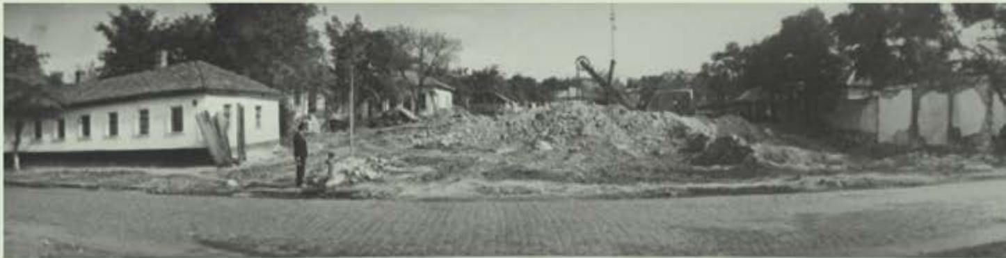
Будівництво нових транспортних магістралей. 60-і рр.
