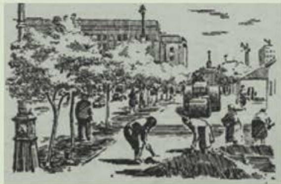
Асфальтирование дороги на Сенной площади. Рис. М. Школьника. 1959 г.
