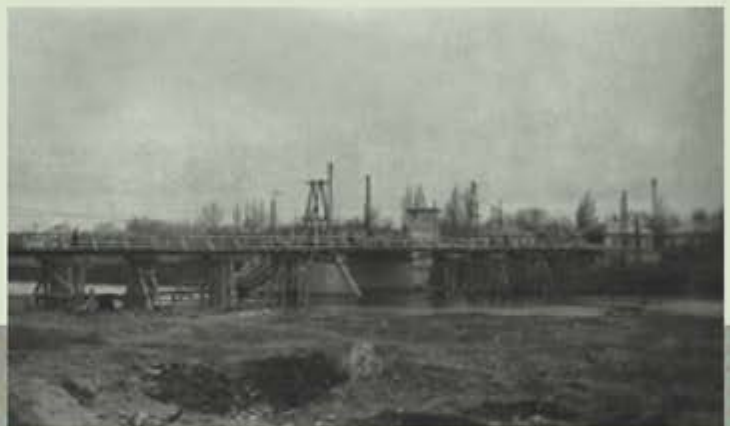
Восстановленный бетонно-деревянно-свайный мост через реку Лугань в районе ул. Заречной, по которому пошел трамвай в Каменный Брод. Авторы инж. Рассадин и Киреев. 1945 г.
