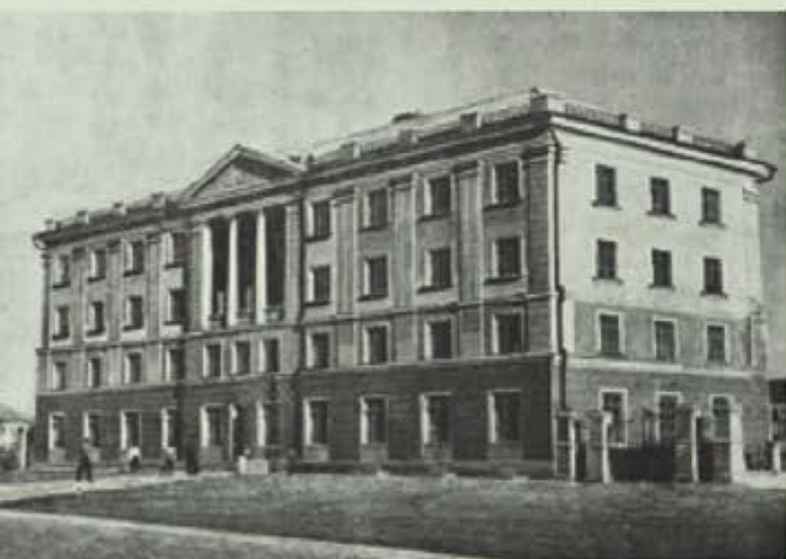
Гуртожиток Гірничого технікуму на вул. Радянській, 62. Автор арх. Є.Є. Цикалов. 1954 р.
