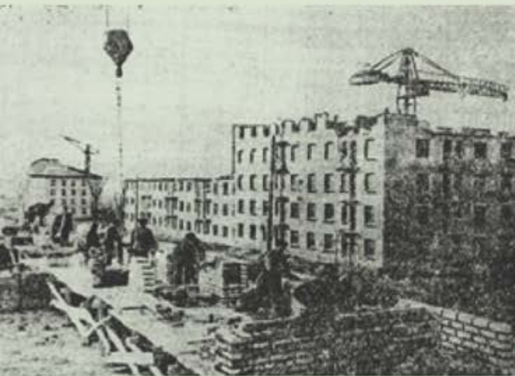
Строительство 40-квартирного дома на ул. Алексеева для работников облстройтреста. Арх. Г.Т. Ракитин. 1958 г.
